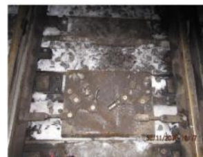
Fig. 2 Dispozitivul ajutător de manevrare cu arc (DAM) aferent macazului nr.3
